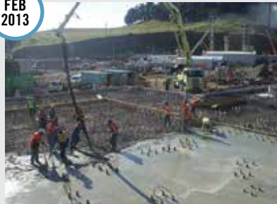
Concrete pour of main foundation slab
